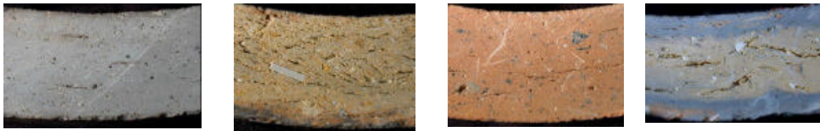
Schnitte von ausgebauten Tonrohren
